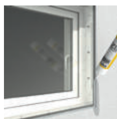
3. Abdichten mit Hain-Dichtmittel
