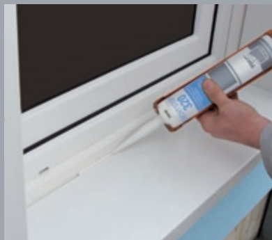
Die Verriegelung zur Stoßkante muss abgedichtet werden.
