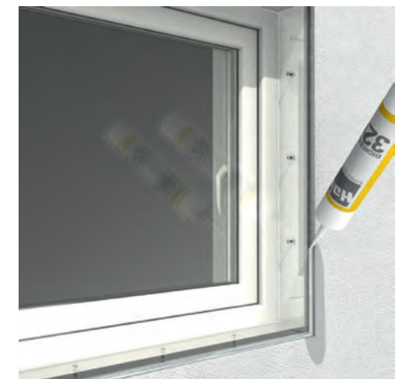
5. Abdichten mit Hain-Dichtmittel
