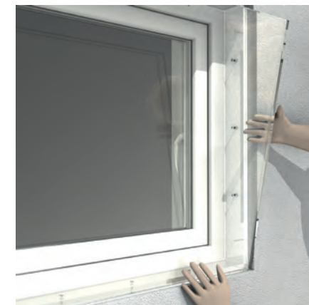
4. Einsetzen der Vorsatzscheibe
