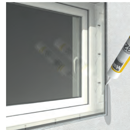
3. Abdichten mit Hain-Dichtmittel
