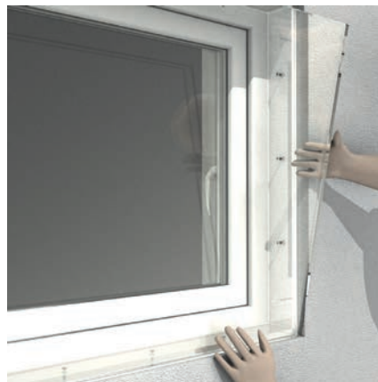
4. Einsetzen der Vorsatzscheibe
