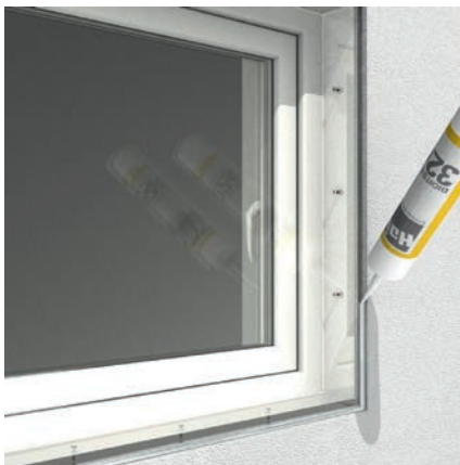
3. Abdichten mit Hain-Dichtmittel
