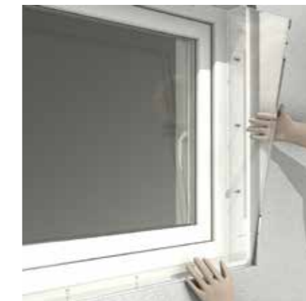
4. Einsetzen der Vorsatzscheibe
