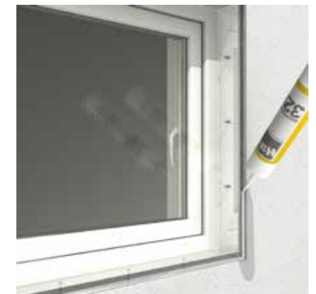
5. Abdichten mit Hain-Dichtmittel
