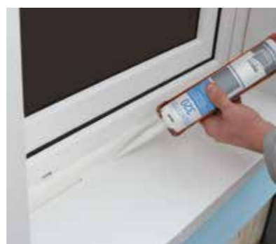
Die Verriegelung zur Stoßkante muss abgedichtet werden.
