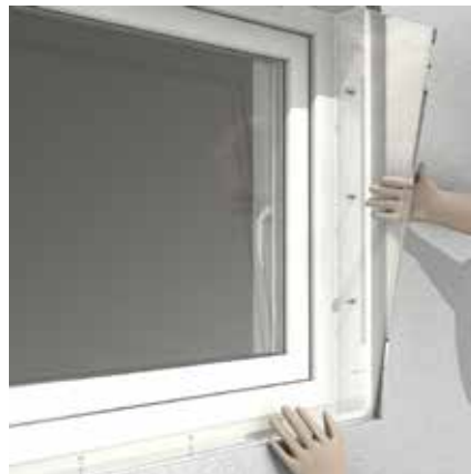
4. Einsetzen der Vorsatzscheibe
