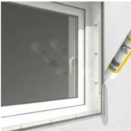
3. Abdichten mit Hain-Dichtmittel
