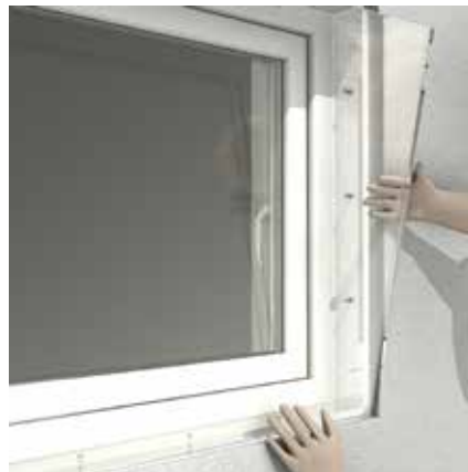
4. Einsetzen der Vorsatzscheibe
