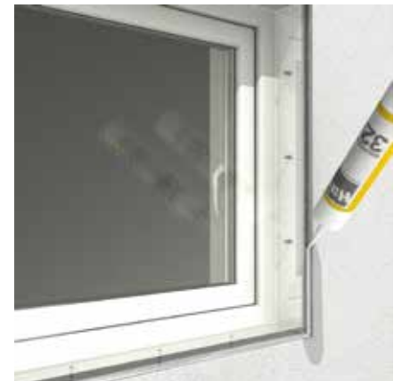
5. Abdichten mit Hain-Dichtmittel
