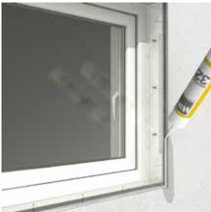
3. Abdichten mit Hain-Dichtmittel
